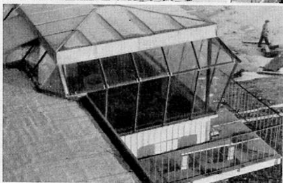
Här ovan meteorologernas ballongfyllningsrum med den mot alla vindar skyddade viseringsplattformen. T. v. två bilder av flygledaretornet, som åtminstone ser ändamålsenligt ut.
