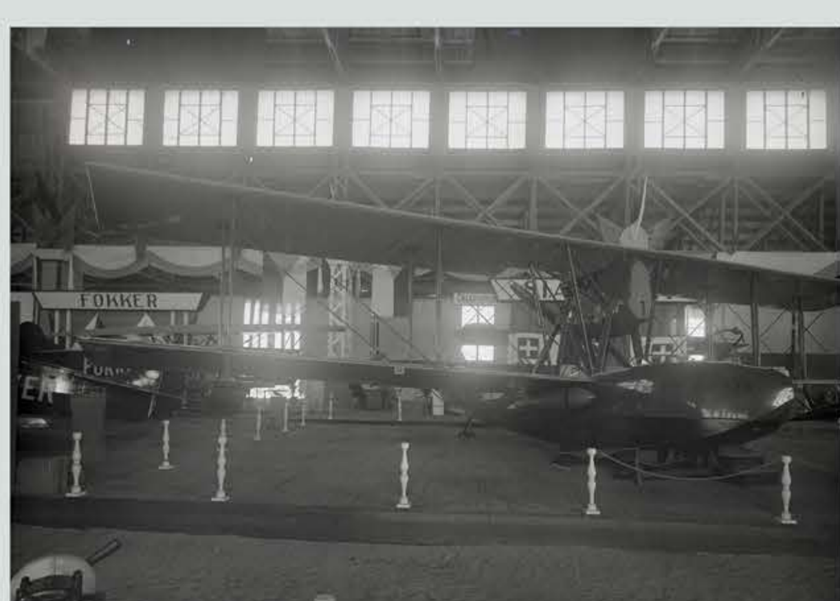
Det enda italienskdesignade och -konstruerade flygplanet på ILUG var en flygbåt av typen Savoia S.16bis M, utrustad med en 300 hk Fiat A.12bis-motor. Flygbåten var en vanlig militärtyp med tre säten och liknande flygplan levererades till den spanska militär- och sjöflygtjänsten.
