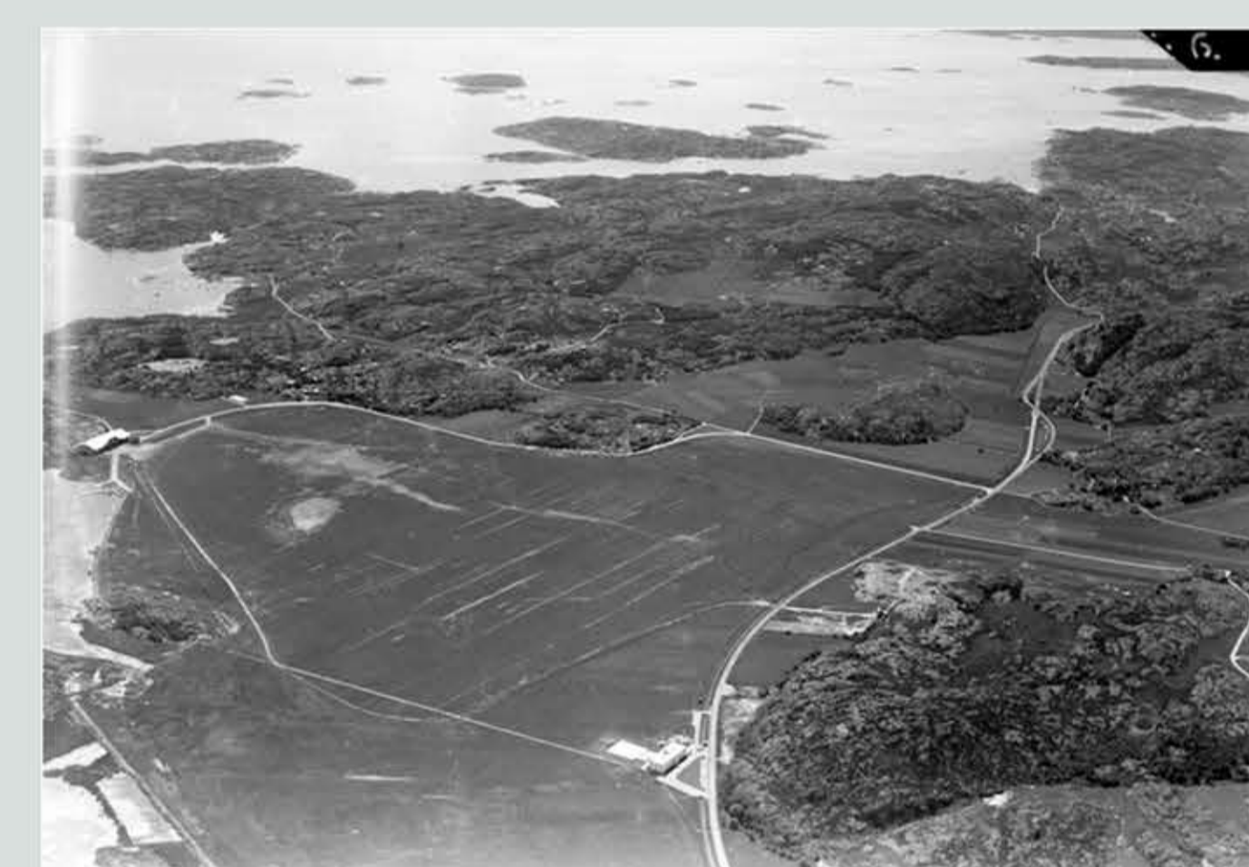
Vy över bansystem från nordväst, notera att det fortfarande var ett gräsfält. Stationsbyggnaden som kan ses till höger i bild stod klar 1937. Framför byggnaden är en hårdgjord yta på cirka 1 200 kvm varav stora och tjocka betongplattor täckte 900 kvm, avsedda för parkerade flygplan.
