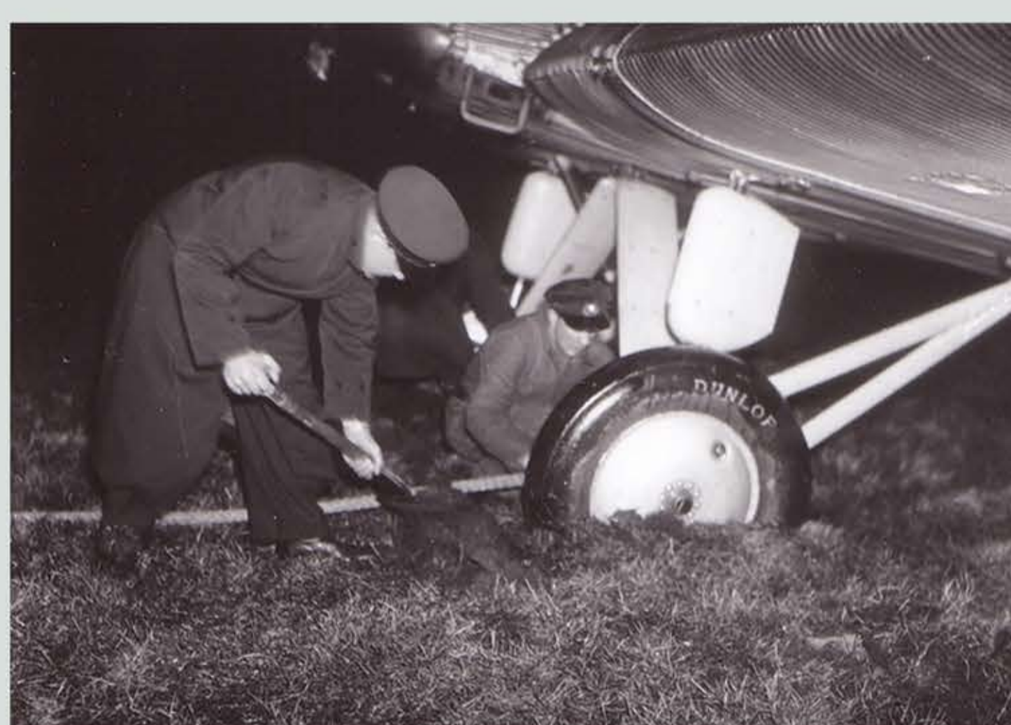
Den sankna marken på vissa områden ställde till bekymmer för flyget, genomsjunkningar av hjul som på bilden och i värsta fall, kapoteringar, dvs. flygplanet välte framåt.
