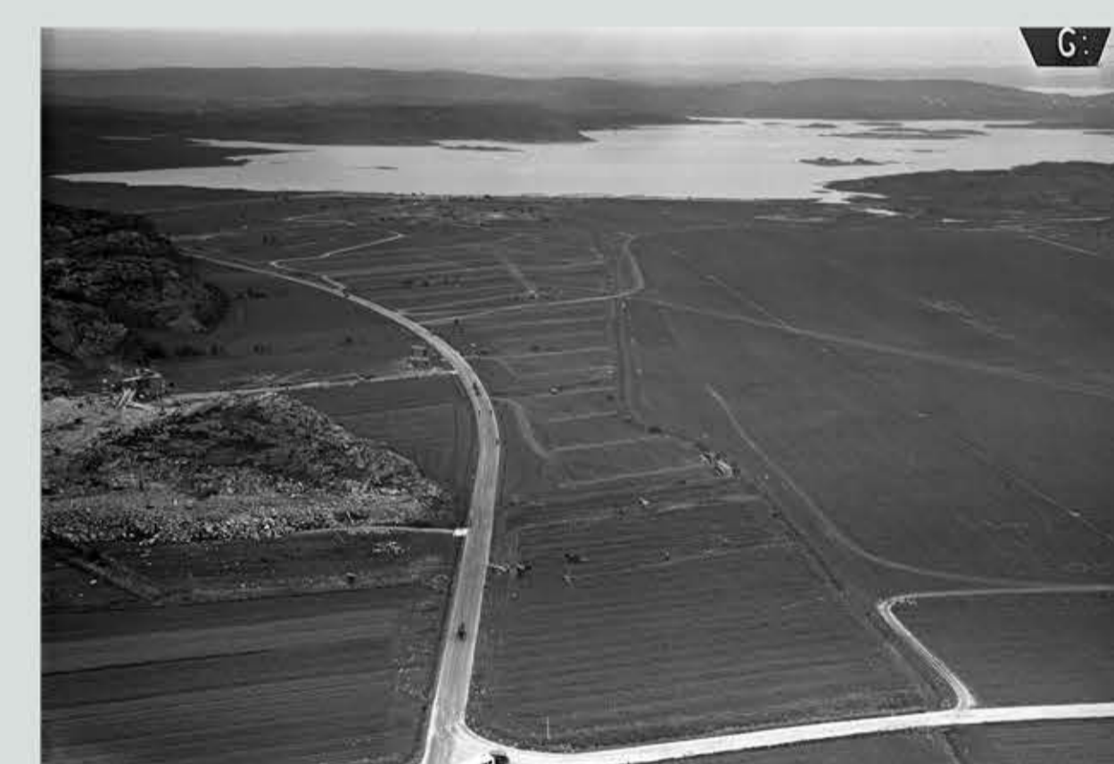
Vy över fältet från väster, bortsprängning av bergknalle i ett led att expandera fältet. Hjuviksvägens dragning intill Snäckeberget och det som kommer att bli Flyghamnsvägen ses i bilden.
