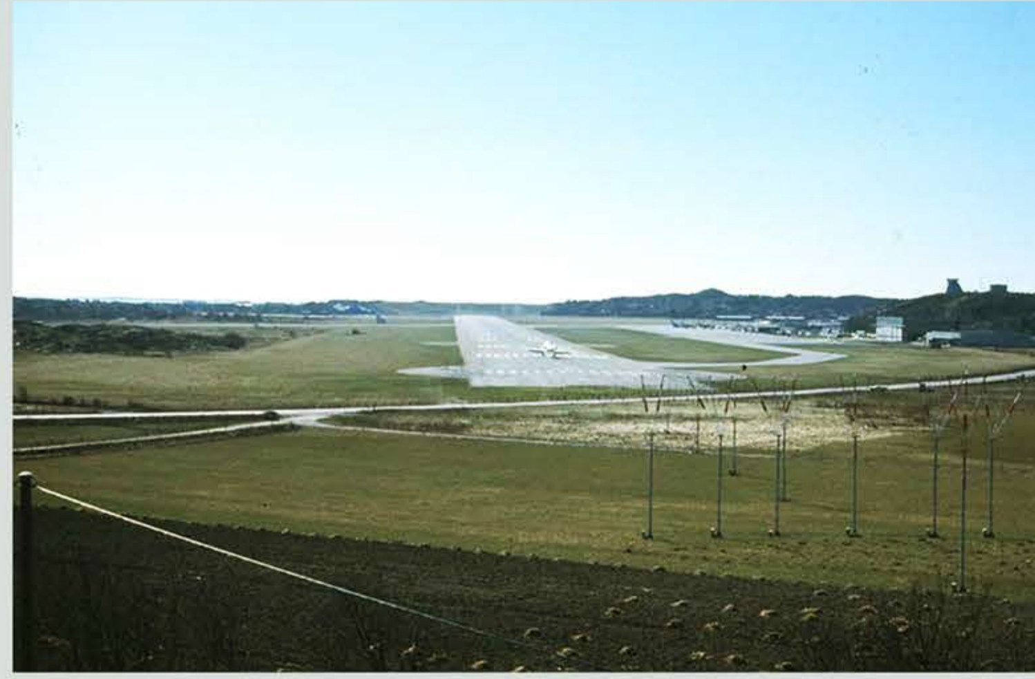
Vy från nordväst över bana 22. Inflygningsljus strax innan bantröskel ses till höger. Ljusen står på gården Buurs betesmarker. Jordbruket är fortfarande i gång på många gårdar i Torslanda.
