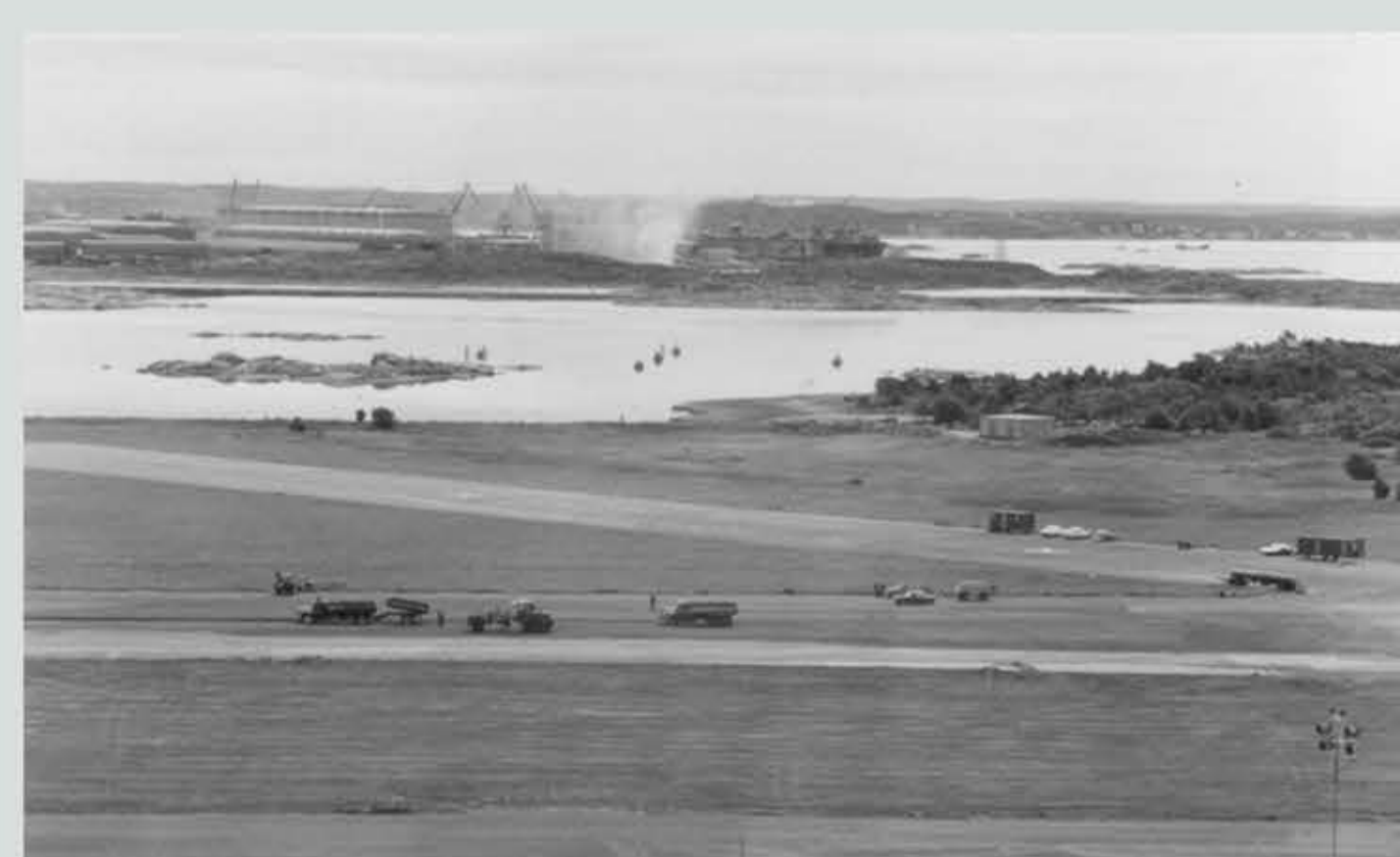
Bana 04/22 förlängdes i båda ändarna, men banan hade brister i vattenavrinning genom sättningar som skett genom åren. 1971 genomfördes därför en omfattande renovering av banan som blev avstängd under två månader. Asfalteringsarbete pågår i bilden. Tjockleken blev till slut ca 40 cm.
