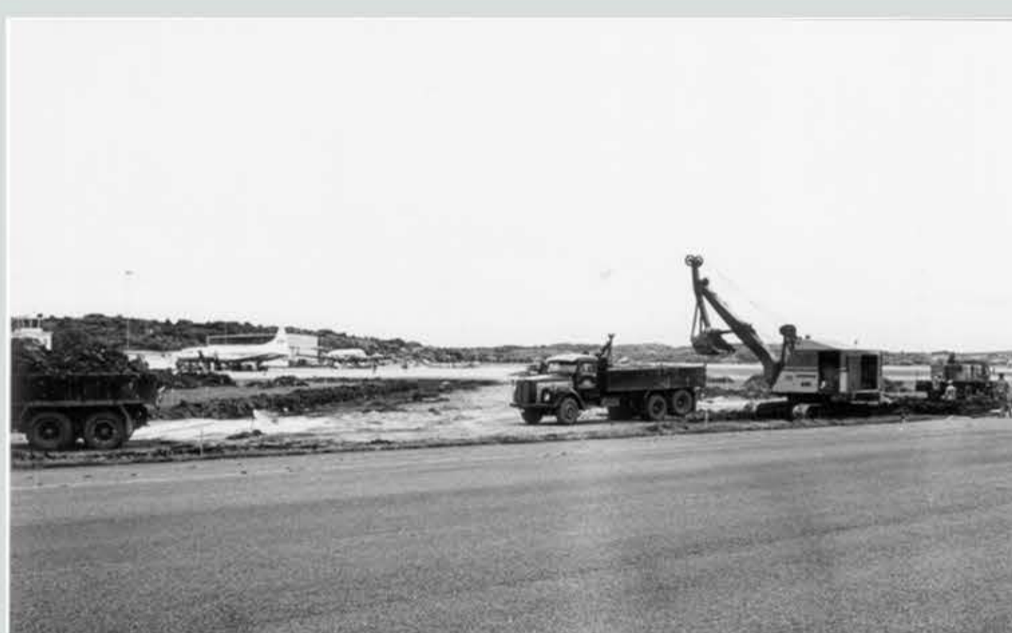
Banorna förstärktes och utökades i omgångar under 60-talet. Även plattorna framför stationsbyggnaderna, benämnda ramper, byggdes ut rejält för att kunna hantera alla flygplan, speciellt chartertrafiken som hade ökat betydligt sedan starten i slutet av 50-talet.
