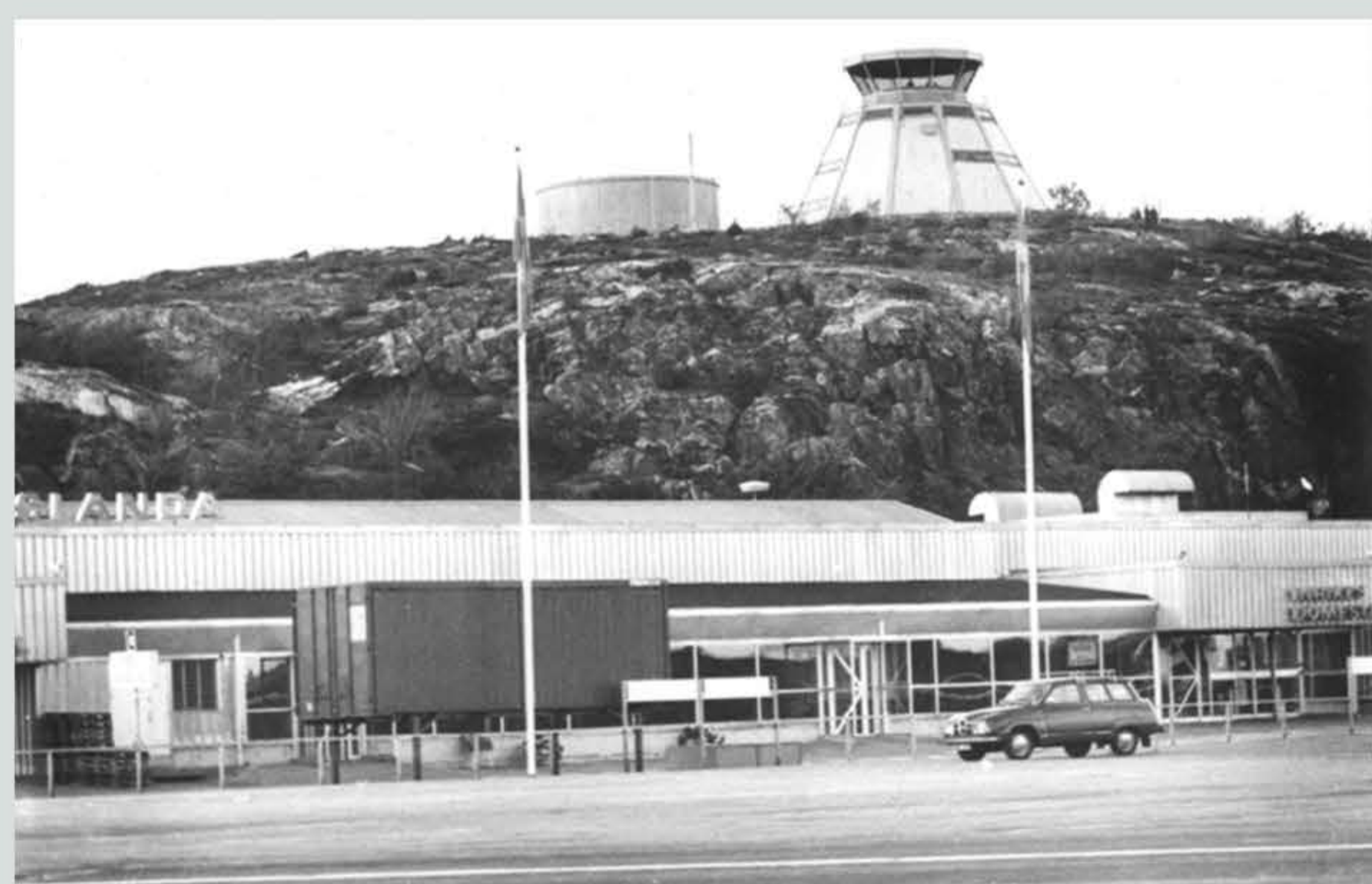
Vy från plattan mot nya stationsbyggnaden. Vattentorn och trafikledartorn i bakgrunden. SAAB 95 som någon form av tjänstebil.
