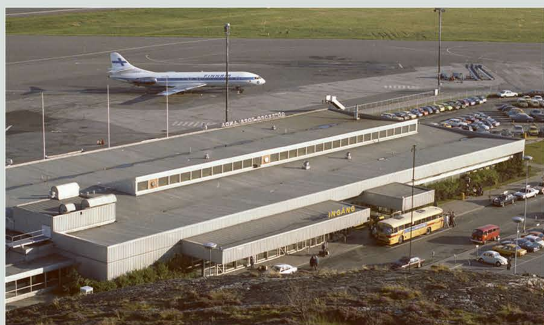
Vy från berget. Flygbussen kan ses vid entrén. På plattan står en Finnair SUD Caravelle.
