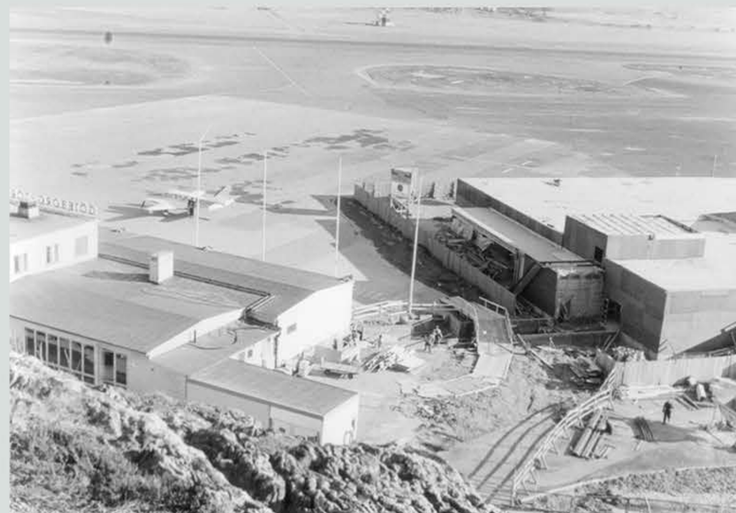
Den nya stationsbyggnaden under uppbyggnad 1969.
