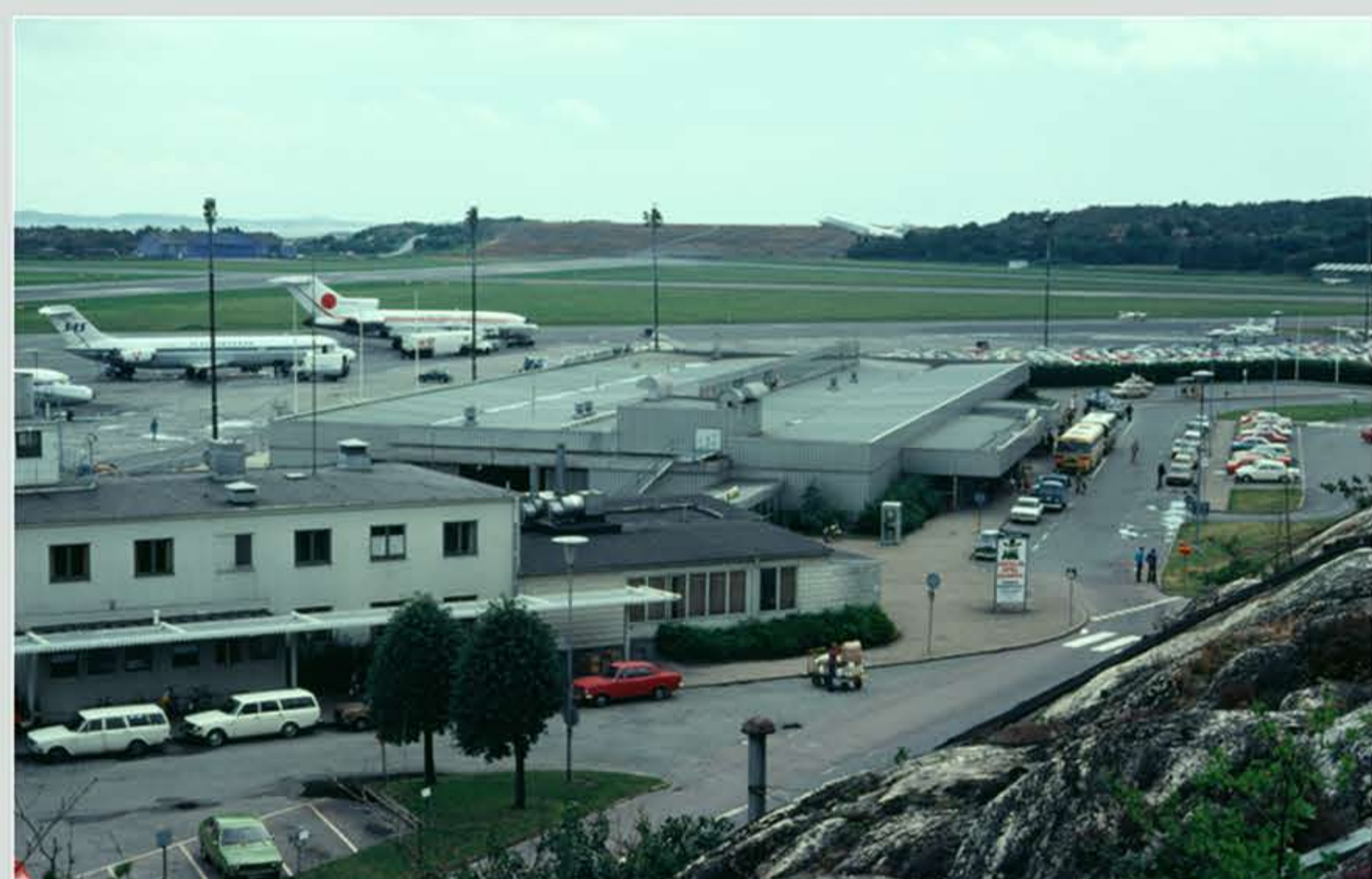
Översikt över stationsbyggnaderna mot syd-väst Flygbussen står som brukligt vid entrén till nya stationsbyggnaden. På plattan syns SAS DC-9or som var vanligt förekommande och en Transair B 727.
