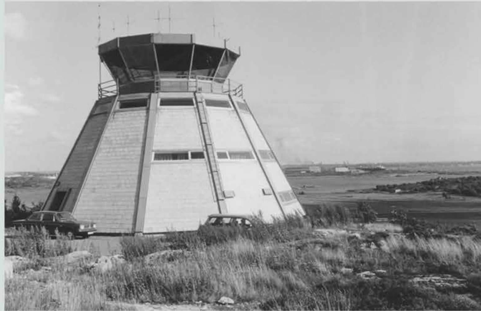
Ett välkänt landmärke i Torslanda är ju det som en gång var trafikledartorn. Byggnaden var klar 1969 och fick en tuff start i livet!! Höststormen 69 blåste ut alla fönster och ställde till allmän oreda. Efter nedläggning så har det bland annat varit festvåning med en fantastisk utsikt över Göteborgs inlopp.
