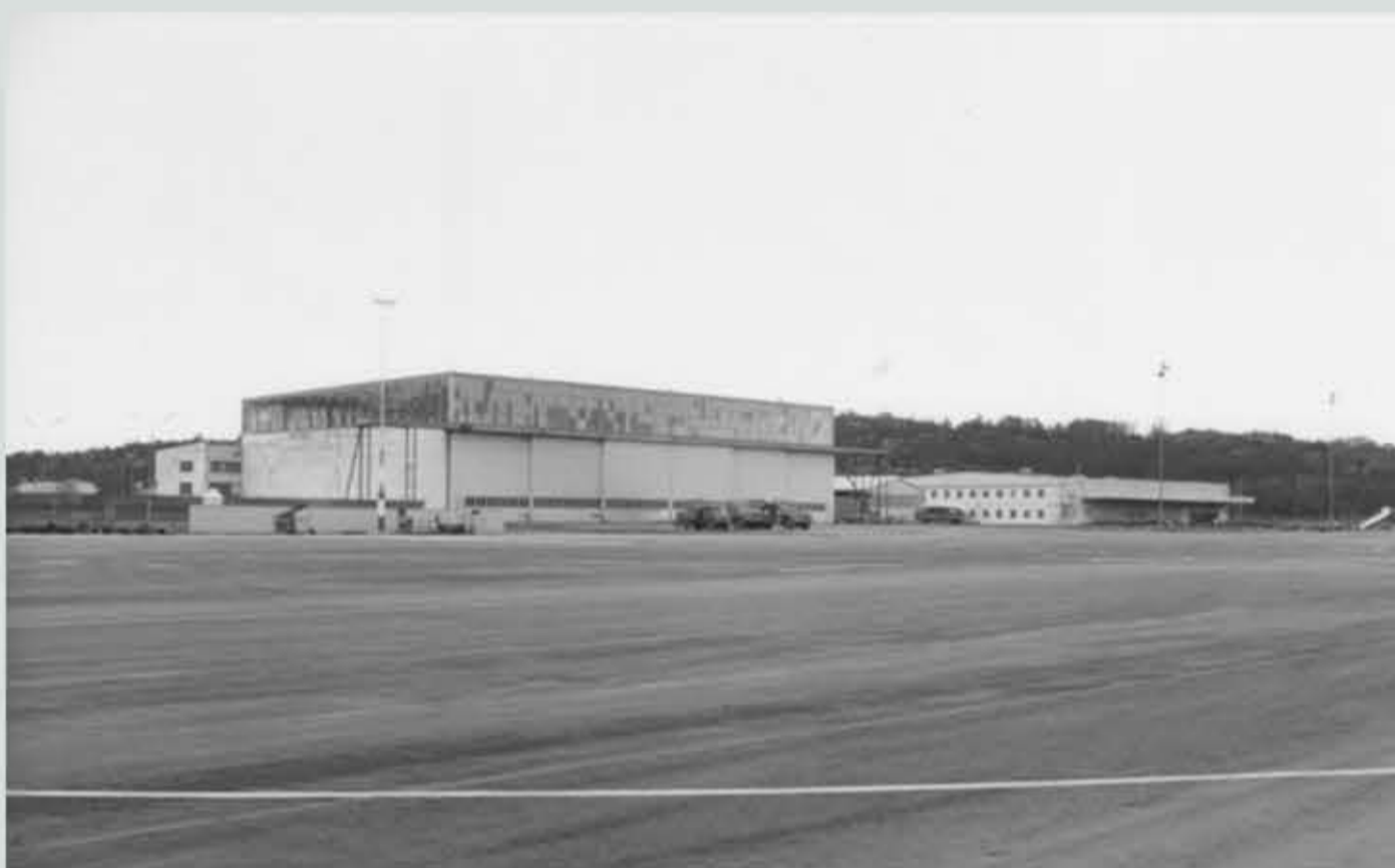
Hangar 2 sedd från landningsbana 04/22. Byggnaden till höger i bild är fraktkterminalen där gods hanterades.
