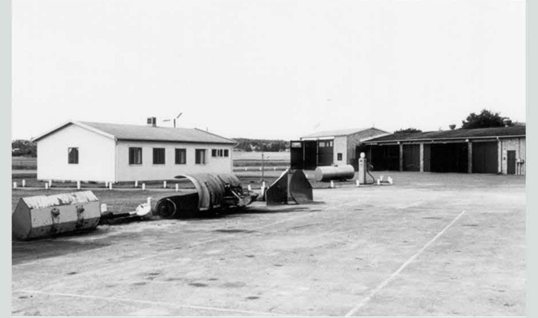
Brandstationen och tillhörande garage för brandbilar. Intelligande garage var avsedda för flygplatsens arbetsfordon som tex. traktorer för gräsklippning och fordon för vinterhållning.
