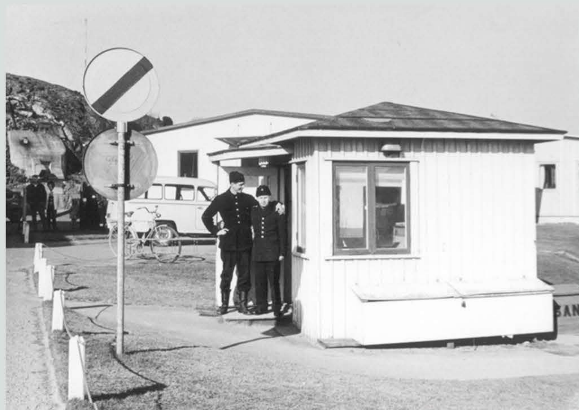
En av de äldre byggnaderna på den nordvästra sidan av flygfältet är vaktkuren vid stationsbyggnaden. Det var ganska obefintligt med staket och avgränsningar mellan fältet och det allmänna, men det fanns en vakt som såg till så ingen obehörig kom ut på fältet.
