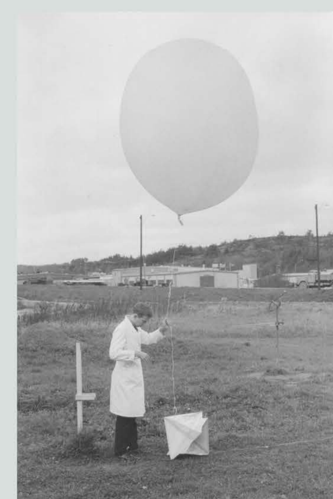
Meteorologerna på Torslanda fick så småningom ett eget hus – Aerologen. Varje dag släppte man upp en väderballong där man kunde få fram vindstyrka och vindriktning, lufttryck med mera.
