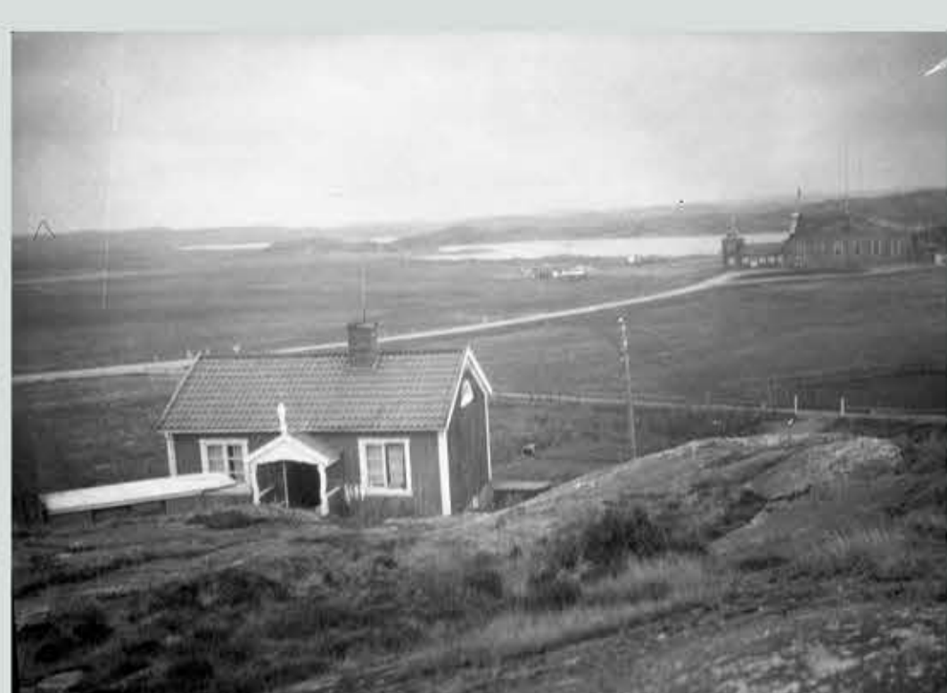
Huset i förgrunden är den tjänstebostad som byggdes till Einar Erikson och hans familj. I bakgrunden syns den blå hangaren.
